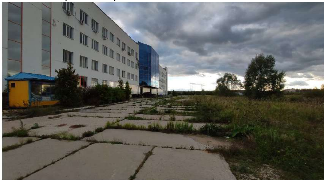
34. площадка, производственное здание
